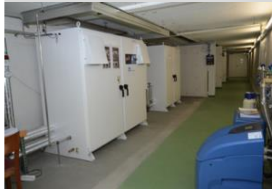
H 2 Energys Produktionsanlage und Trailer
